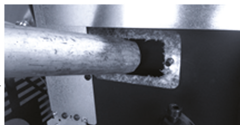
Fig.94 Aspiration des suies par les trappes latérales
