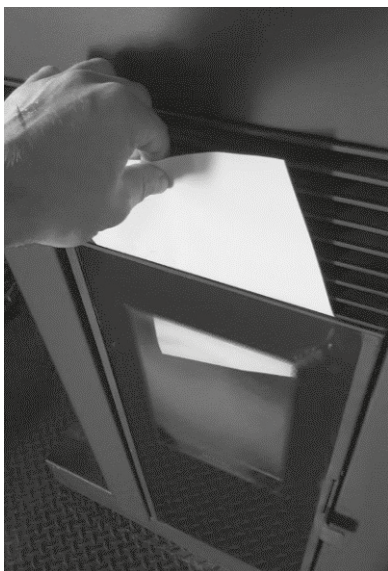
Fig.99 Vérification de l'étanchéité de la porte
