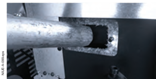
Fig.94 Aspiration des suies par les trappes latérales
